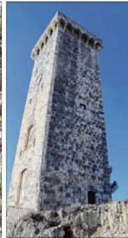
Le bâtiment ne présente pas de danger d'effondrement, mais commence à pencher.
