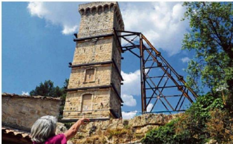
Deux bras métalliques soutiennent la tour de l'Horloge et ses 23,50 mètres de haut. /PHOTO S.D.
