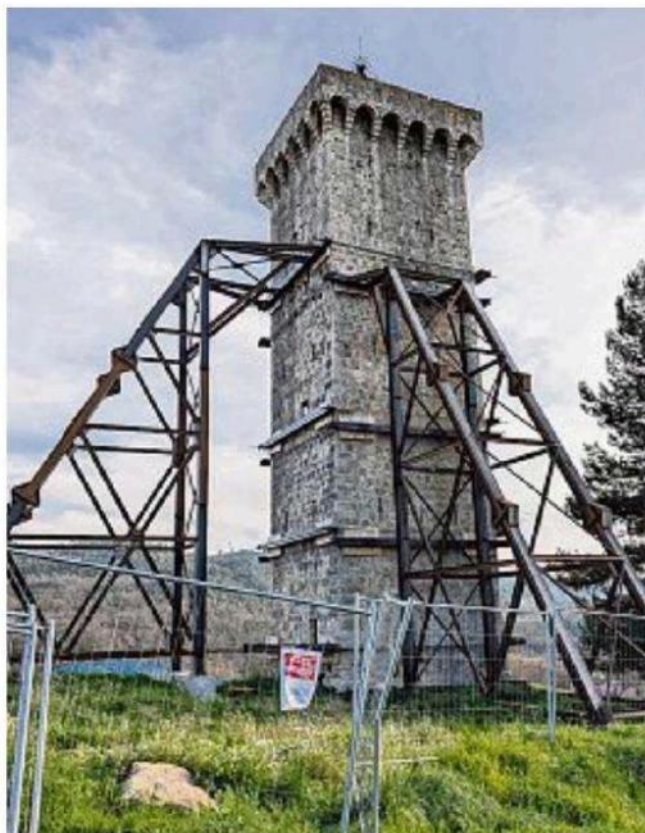
La tour de l'horloge a besoin d'être restaurée. / PHOTO T. DZ
