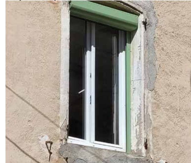
coffre de volet roulant apparent, ne respectant pas le dessin en arc cintré
