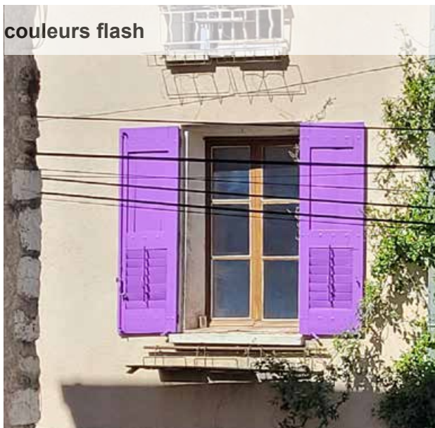
appui béton et enduit ciment non adaptés
