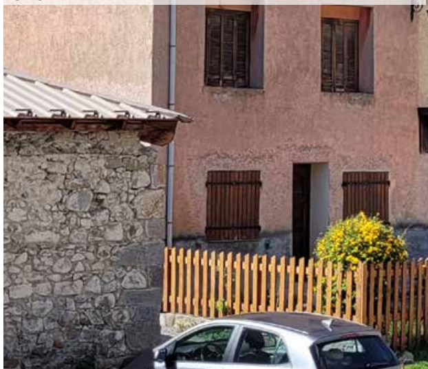
couleurs flash et finition d'enduit trop en relief
