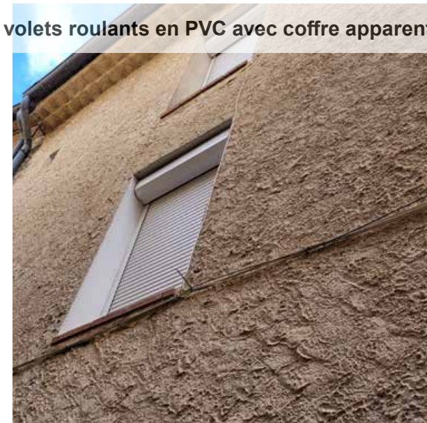
appui béton et enduit ciment non adaptés
