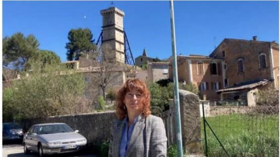
La maire s'est vite inquiétée des fragilités de la tour et a fait installer deux contrefiches pour éviter qu'elle s'effondre sur les maisons du village. PHOTO L.D.
